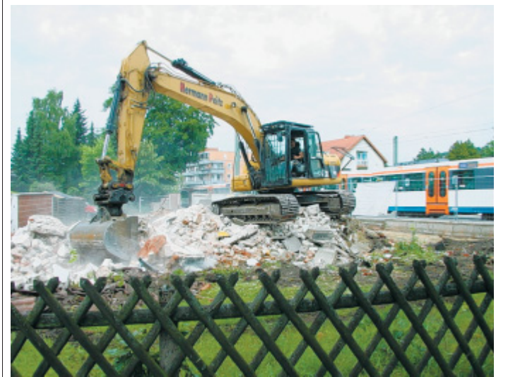
Ganze Arbeit: Die Mitarbeiter der Abbruchfirma haben die ehemalige Traditionsgaststätte dem Erdboden gleichgemacht.
